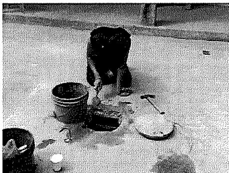
Como podemos observar en el proceso se limpia bien el área a trabajar, con una base de madera ayudara a que la mezcla no se derrame se aplica el hormigón luego esperar para que fragüe y darle el acabado adecuado.
