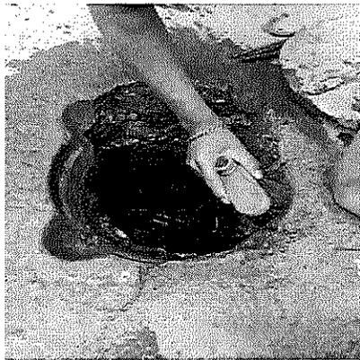
En la imagen muestra los procedimientos de cómo se debe de realizar un ajuste de hormigón antiguo con hormigón nuevo lo correcto es limpiar y luego aplicar SIKA dure # 32 esto para unirlo.
