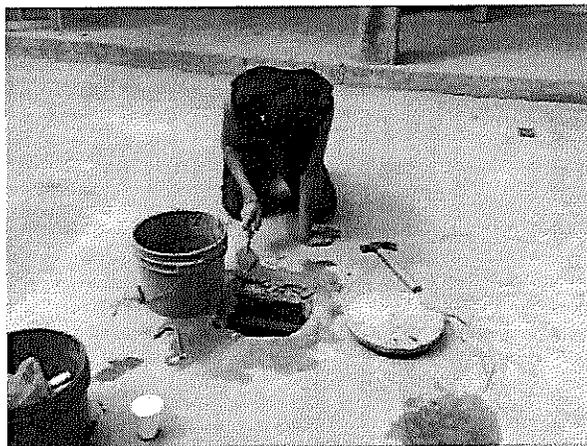
Como podemos observar en el proceso se limpia bien el área a trabajar, con una base de madera ayudara a que la mezcla no se derrame se aplica el hormigón luego esperar para que fragüe y darle el acabado adecuado.
