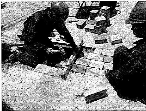
Colocando el adoquín con una guía de madera, que tiene como guía un lado recto, la base de la superficie es ambos lados del adoquinado ya existente.
