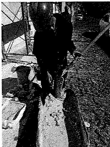
El participante realiza la mezcla (cernido) que se aplicara en el muro manipulando cuchara de albañil, pala, carreta material que utilizaran los albañiles oficiales dando el acabado final del muro
