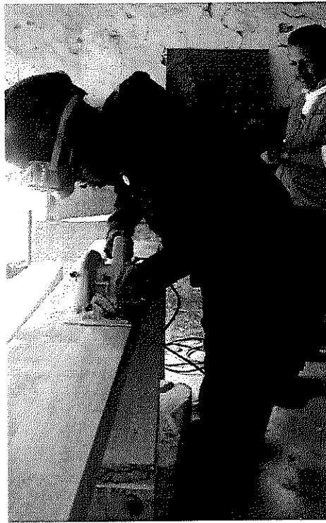
En la imagen distinguimos que el participante de construcción realiza corte de longitudinal de tablonces de 4" x 4" x 9' pies de largo con el objetivo de lograr obtener dos vigas de madera ya que el tipo de tablón es muy incómodo de su manipulación se logra cortarlo a la mitad logrando doble uso
