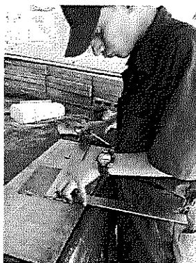
El participante está trazando las medidas en la platinas, para la estructura de metal del patio.
