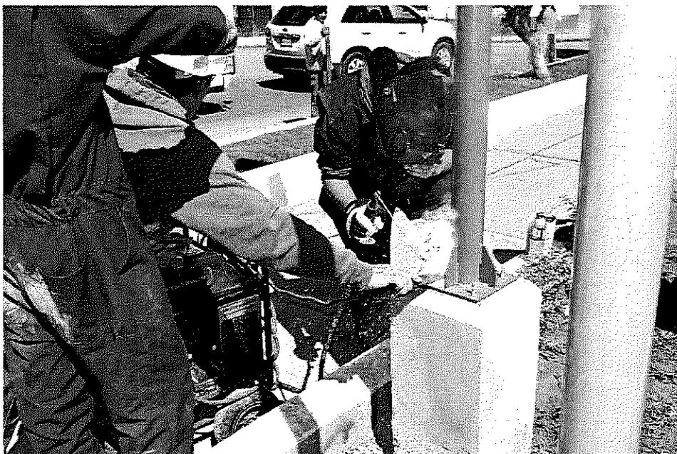
Soldadura de pernos para asegurar a las bases de concreto.
