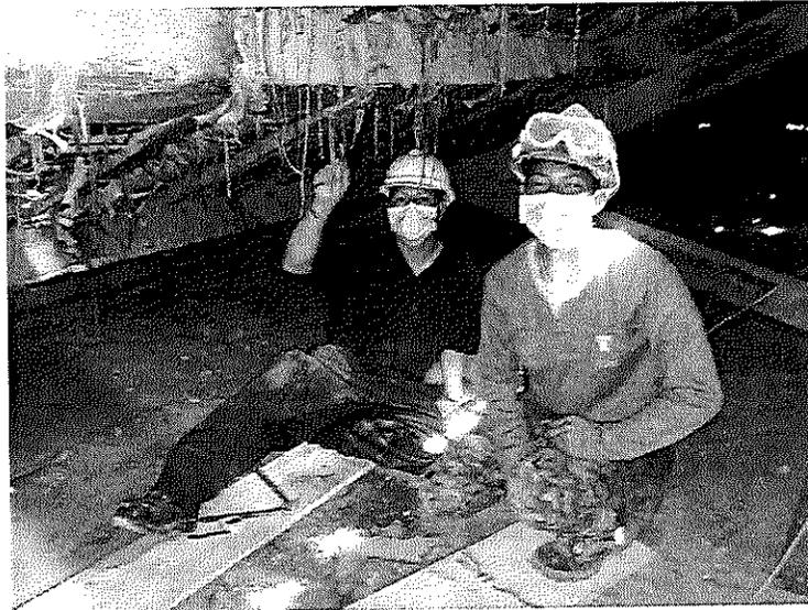
En la imagen analizamos los desperfectos de los techos y distinguir las filtraciones causadas por las lluvias, una vez encontrado los daños se definió que debemos de abrir espacio en el tejado para reparar los daños, las causas de los desperfectos son ocasionados los sismos conforme los movimientos las tejas de arcilla se resbala y es por ello que existen los daños.
