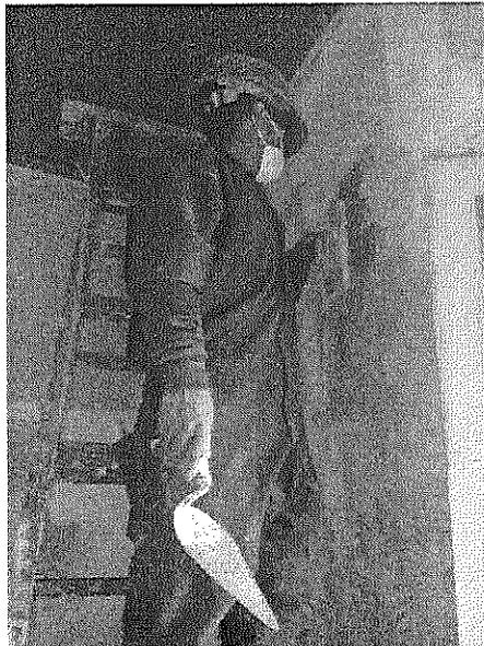
El participante de construcción aplicando el repello en la parte afectada del muro, en el salón de exposiciones del segundo nivel del edificio casa de la cultura Quetzaltenango
