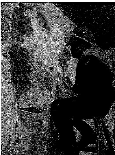
Si distinguimos en la imagen el participante efectúa los trabajos de limpieza de las áreas dañadas su le aplica agua para lavar todo el polvillo y una vez estando húmedo se aplica la mezcla de arcilla y se plancha con agua y una plancha de madera dejando una superficie plana conforme la pared anterior.
