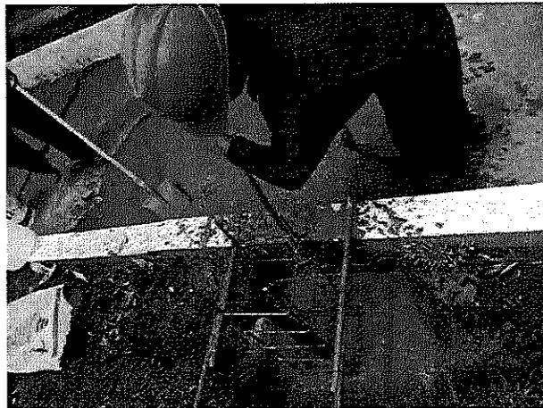
En la imagen distinguimos que los participantes de construcción realizan prácticas de fundición de zapatas para la base de pedestal, el procedimiento es preparar 4 cubetas de arena de río, y cuatro piedrín por una bolsa de cemento y agregar agua, luego se moja el área de la zapata y a llenar la altura de zapata su dimensión es de .60 cm X .20
