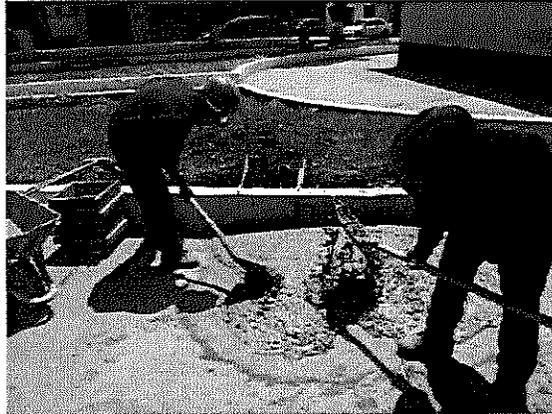
En la imagen se observa que los participantes de construcción realizan prácticas de preparación de concreto (hormigón) para fundir pedestal (base) para poste de iluminación en el parque calvario Quetzaltenango
