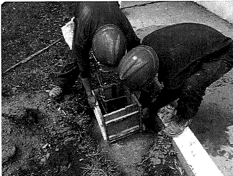
Participantes de construcción efectúan centrado de cajas de madera para fundir la base, estas cajas ya estaban armadas, el primer paso es dejar alineada en dirección al bordillo y con una altura de nivel respetando la altura del bordillo.
