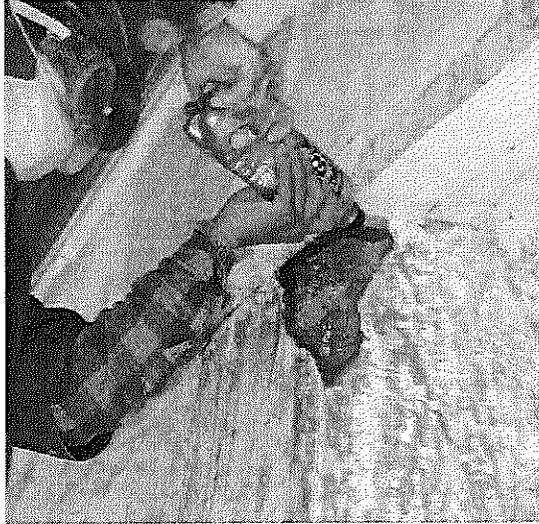
El participante lavando el polvillo de que está impregnado en el la parte dañada del muro para aplicar el mortero compuesto por arcilla y cal, ya que el revestimiento del muro esta con el mismo material, en la casa de la cultura.
