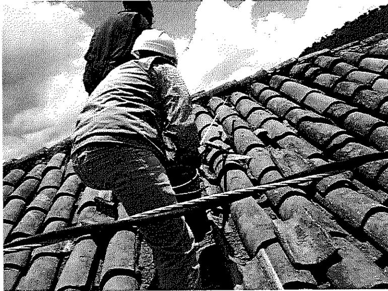
En la imagen se distingue que el proceso es de quitar como mínimo dos hiladas de tejas dejándolas a los lados compartiendo el peso y no recárgalo en una sola área, para tener un balance de peso, ya que la madera es de descendencia antigua, y a la vez tener a la mano las tejas para colocarlas de nuevo y evitar más trabajo de bajarlas.
