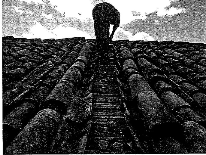
Efectuando el desmontado de las tejas de arcilla para llegar a las áreas afectadas en camino del proceso se logra pasar por los daños ya visualizados anteriormente en donde retornando, su instalación quedara el trabajo terminando de parte de los participantes del taller de construcción.
