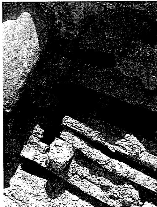
Alguno de los daños observados en el techo de escuela taller Quetzaltenango, estos los desperfectos que requiere arreglos en analizando bien existe las posibilidades de cambio de madera porque las lluvias a través de los años ha logrado deteriorarlo es por ello que se requiere apoyo para la compra de materiales y poder realizar un trabajo formal.
