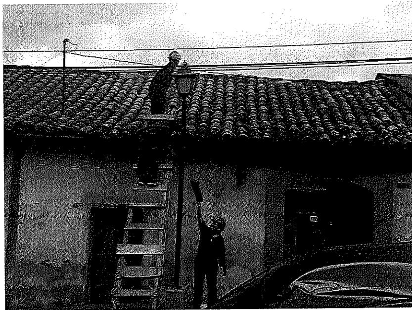
En la imagen distinguimos la colocación de tejas, obteniendo un trabajo ya solucionado y a la vez los participantes llenos de experiencias con cada trabajo que ejecutan, en el área de mojinete se le aplicó una especie de revoque para evitar las filtraciones del agua de lluvia en el techo de escuela taller de Quetzaltenango
