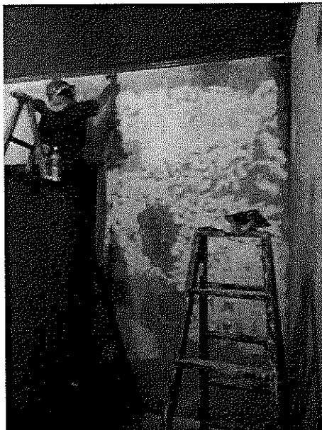
En la imagen notamos que el participante aplica masilla de yeso en muro por tener pequeñas fisuras que tiene el revestimiento del muro el objetivo es sellar las fisuras y luego proceder a lijar dejando la superficie lisa para aplicar la pintura en el salón casa de la cultura Quetzaltenango.
