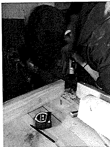
Perforación con barreno y broca de paleta para ensamblar con clavijas
