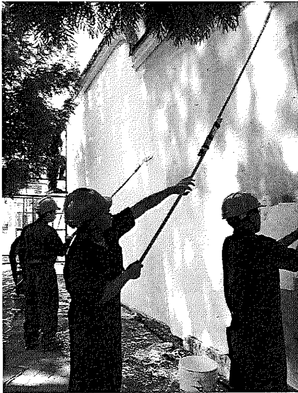
En la plazuela San Antonio, participantes del taller de electricidad pintan la pared con pintura color blanca.
