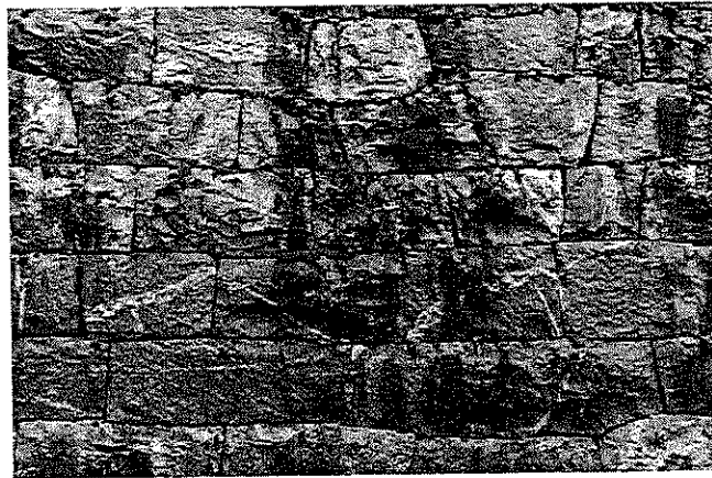
Superficie afectada por ataque biológico (hierbas, musgos...)
