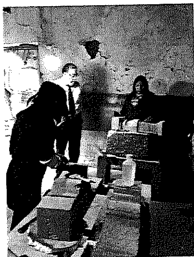
A continuación, se presenta directora de escuela taller y al Alcalde municipal en la supervisión constante de las balaustradas faltantes
