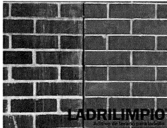
En la imagen se observa el proceso de la limpieza, el trabajo se realiza con ladrilimpio, es un químico que limpia eflorescencias y manchas en ladrillo, baldosa, teja o cualquier pieza de arcilla. Remueve el hongo, moho, salitre, carbonataciones y cualquier mancha generada por humedad. Limpia y neutraliza la superficie por lo que previene futuras eflorescencias. No cambia el color, resalta el tono natural de las piezas. Es un producto amigable con el medio ambiente, no quema.
